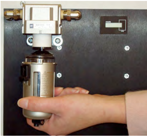
Figure 14c : Tirez vers le bas le boîtier filtre
